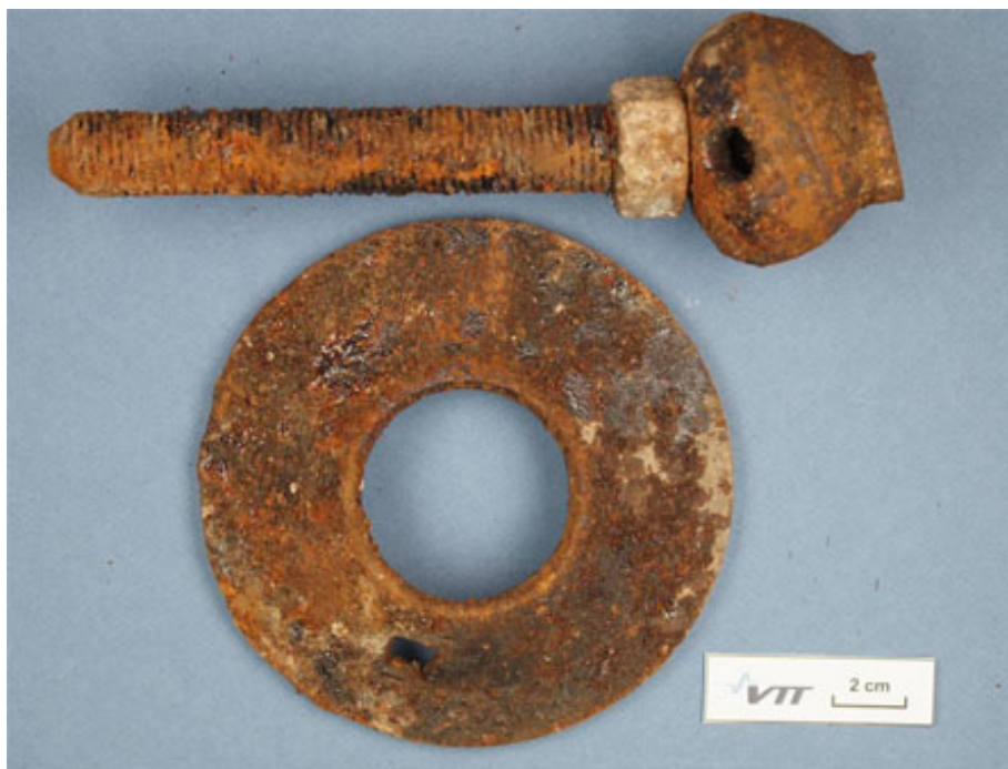
Kuva 3. Vuoden vanhan kallioankkurin pää aluslevyineen.
