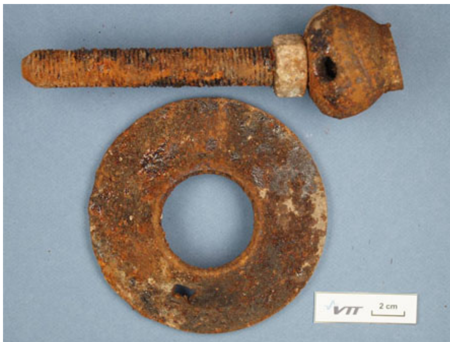
Kuva 3. Vuoden vanhan kallioankkurin pää aluslevyineen.
